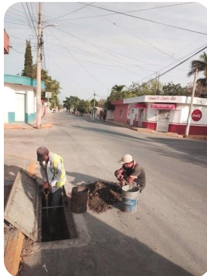
Limpieza de alcantarillas en la ciudad, por parte de personal del Ayuntamiento.
