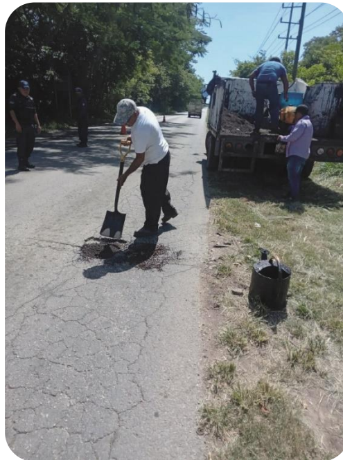
Programa permanente de bacheo en calles y carreteras del municipio.
