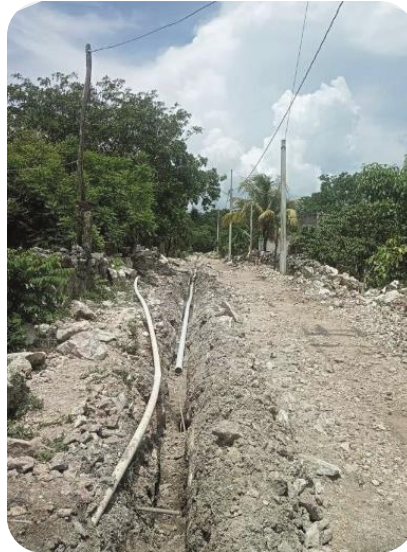
Obra de ampliación de red de agua potable en la colonia Santo Domingo.
