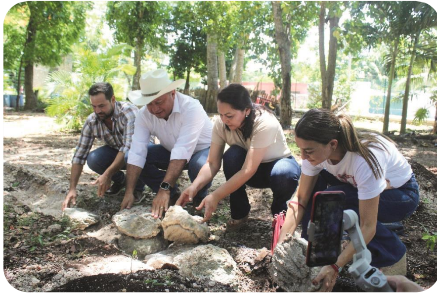
Colocación de la primera piedra para la construcción del recinto que albergará al emblemático tapir.
