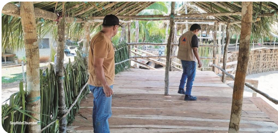
Supervisión de las medidas de seguridad en la construcción del coso taurino en el marco de la Feria de Reyes Tizimín 2023.
