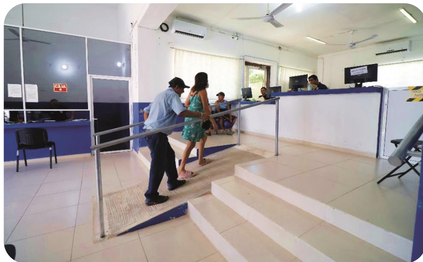
Construcción de rampa para discapacitados en las oficinas del Catastro.
