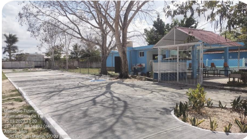
Construcción de banquetas del jardín de niños Cristóbal Colón.
