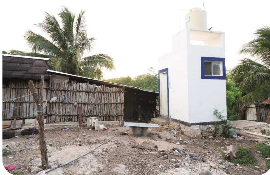
Construcción de baños en la colonia Comichén.
