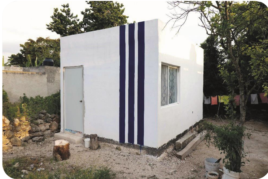
Construcción de vivienda en la colonia Nabalám.
