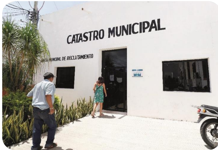
Remodelación de las instalaciones del Catastro.
