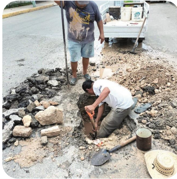
Reparación de tubería del sistema de agua potable en Tizimín.
