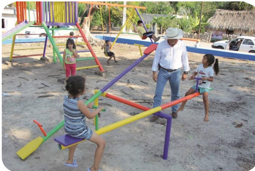
Reconstrucción de parque en la comisaría de Cabichén.
