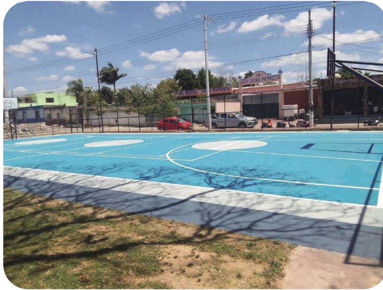
Rehabilitación de la cancha de usos múltiples de la Rejollada.
