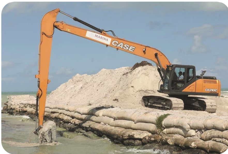
Dragado del puerto de abrigo con maquinaria de la Secretaría de Marina (SEMAR).
